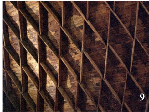
preiswert zu errichten. Auch Zollinger befasste sich mit der „fabrikmäßige[n] Massenherstellung von typisierten Konstruktionen“<sup>7</sup> und meldete seine Lamellenkonstruktion im Oktober 1921 zur Patentierung an, die ihm zwei Jahre später erteilt wurde.
